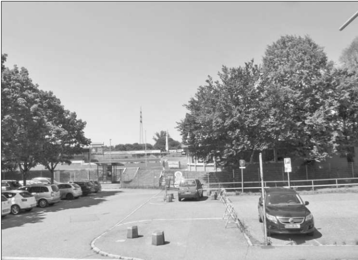
Vorher. Rund ums OFV-Stadion besteht erhöhter Sanierungsbedarf. Der Standort soll zu einem Anziehungspunkt der LGS werden. Foto: Bode
